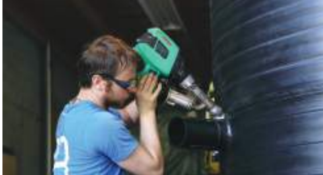
Удобный WELDPLAST S2 в работе
